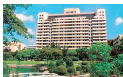
上海交通大学附属第六人民医院 外観
